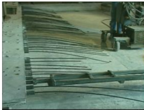
Рис. 3. Армирование плит перекрытия высокопрочными тросами
