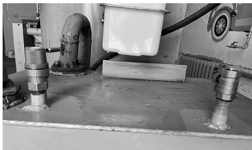
Рисунок 2 – В бак гидрозатвора установлены взрывной клапан (слева) и патрубок для загрузки воды (справа) Figure 2 – An explosive valve (left) and a patube for loading water (right) are installed in the hydraulic lock tank
