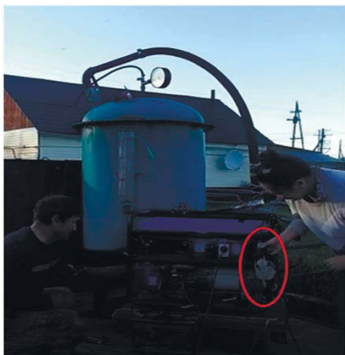
Биогазовая линия с газогенератором
